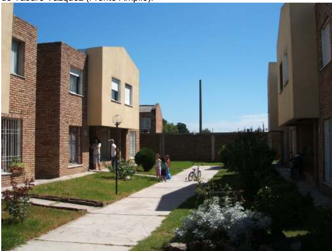
2. Viviendas de construcción cooperativa por ayuda mutua: Complejo de la cooperativa COVIESS 90-II, integrada en FUCVAM. C/ Cambay, esquina Campoamor. Nordeste de Montevideo (Foto CONOSUD)
