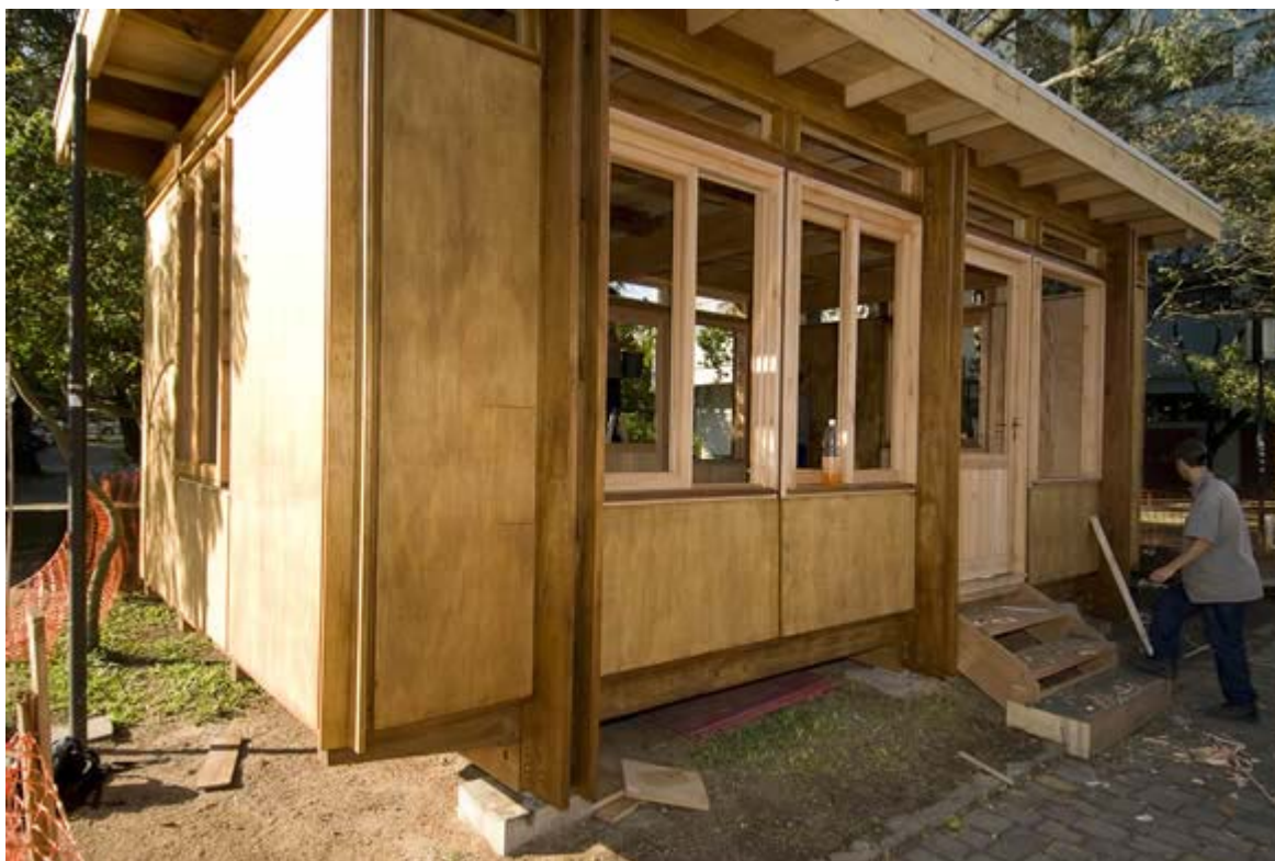
3.- Espai construït en la Universitat federal de Porto Alegre, amb materials ecològics i respectuosos amb l'entorn mediambiental, per allotjar iniciatives d'economia solidària i comerç just. (Foto: FBES)
